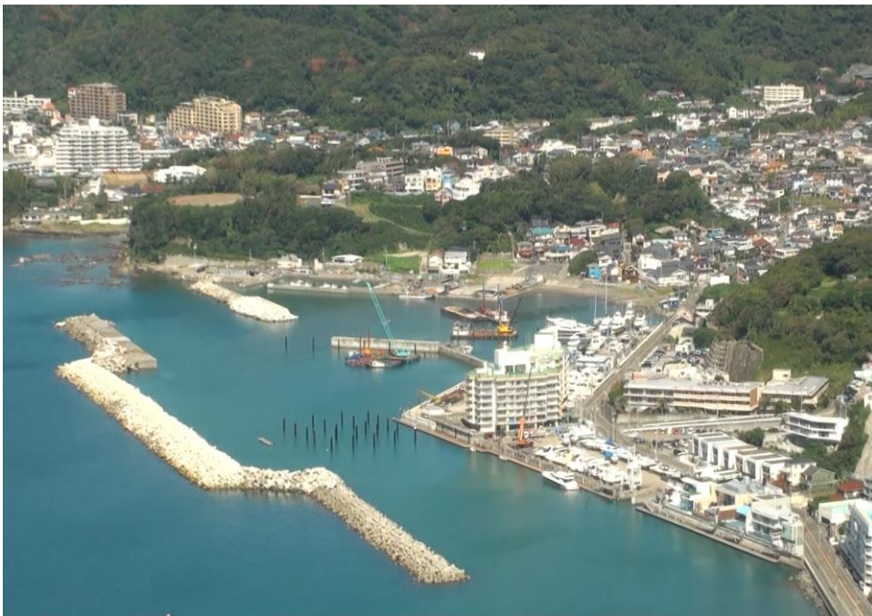
2020 年 9 月 28 日のヘリ空撮画像。市有の「芦名 4 号防波堤」に不法に連結して、漁協による離岸堤が延長された。マンション地先の消波ブロックも撤去され、杭が打たれている。 動画あり
